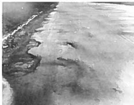
Rupturi de margine cu văluriri și refulări
